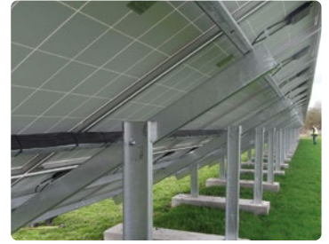
Zapata de hormigón Concrete foundation
