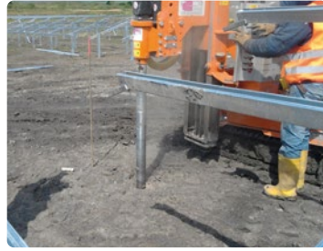
Perforado + hincado Predrilling
